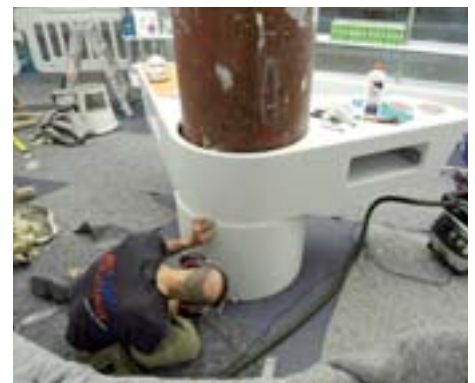
Verkleidung der Stahlbetonstütze: Hier werden die Segmente und Elemente montiert
