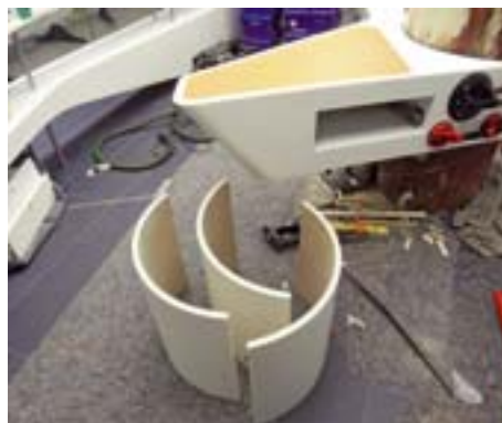
Die runde Säulenverkleidung wurde in einzelnen Segmenten vorgefertigt
